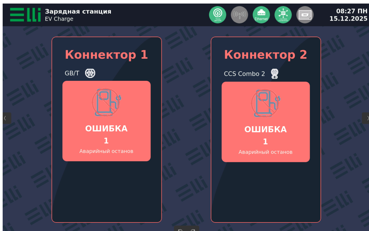
Рисунок 17. Вид основного экрана управления панели оператора с информацией о нажатии аварийной кнопки
